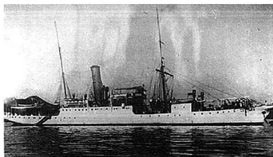
小笠原丸 海底ケーブル敷設船 三菱重工業長崎造船所建造
